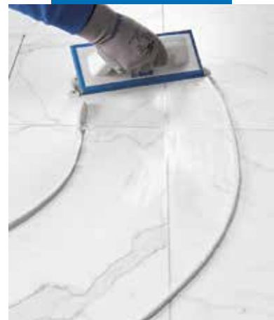
Spoinowanie płytek imitujących kamień naturalny
