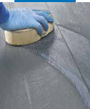
Czyszczenie i profilowanie fug przy użyciu gąbki celulozowej
