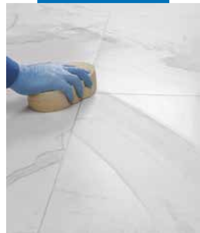
Czyszczenie i profilowanie fug przy użyciu gąbki celulozowej
