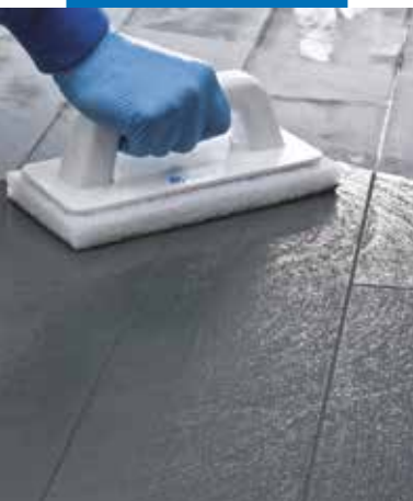
Czyszczenie spoin za pomocą pacy typu Scotch-Brite® (spoina częściowo utwardzona)
