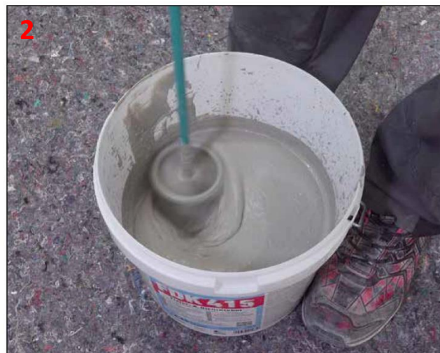
2 Sopro FDK 415: składnik płynny B wlać do czystego pojemnika i przy pomocy mieszarki wymieszać ze składnikiem proszkowym A, aż powstanie jednolita, bez grudek, masa.
