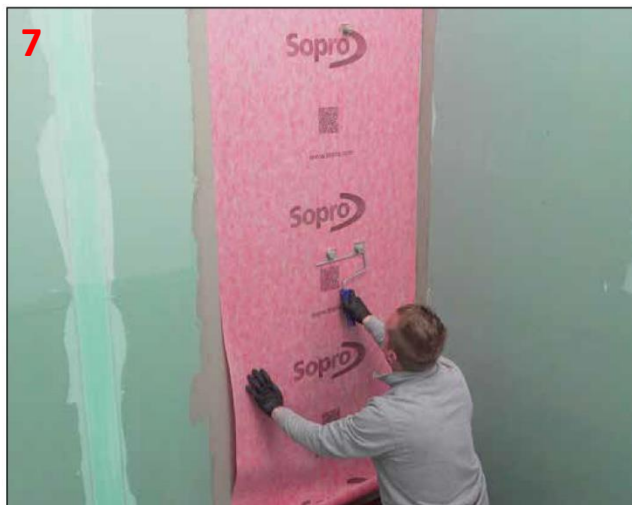
7 Przycięty na wymiar odcinek maty Sopro AEB® 640 przyłożyć do świeżej warstwy kleju rozprowadzonego na podłożu, mocno docisnąć matę od środka do kierunku krawędzi.
