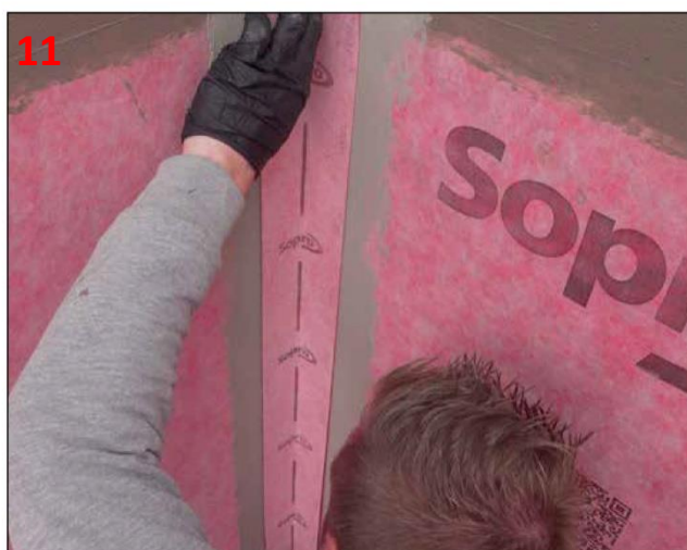
11 Odpowiednio przycięte odcinki taśmy uszczelniającej Sopro AEB® 148 przyłożyć do podłoża pokrytego świeżą warstwą kleju wodoszczelnego lub zaprawy uszczelniającej i mocno docisnąć.
