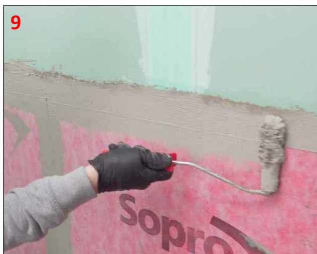
9 Krańcowe odcinki maty Sopro AEB® 640 obrobione również klejem wodoszczelnym Sopro FDK 415 lub zaprawą Sopro DSF® RS 623.
