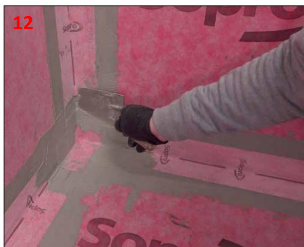
12 Zakończenia taśmy AEB® 148 również obrobić klejem wodoszczelnym Sopro FDK 415 lub zaprawą Sopro DSF® RS 623.
