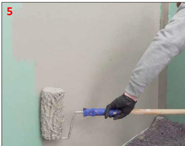
5 Zalecamy nakładanie kleju wodoszczelnego Sopro FDK 415 lub zaprawy Sopro DSF® RS 623 w warstwie o równomiernej grubości na całej powierzchni.
