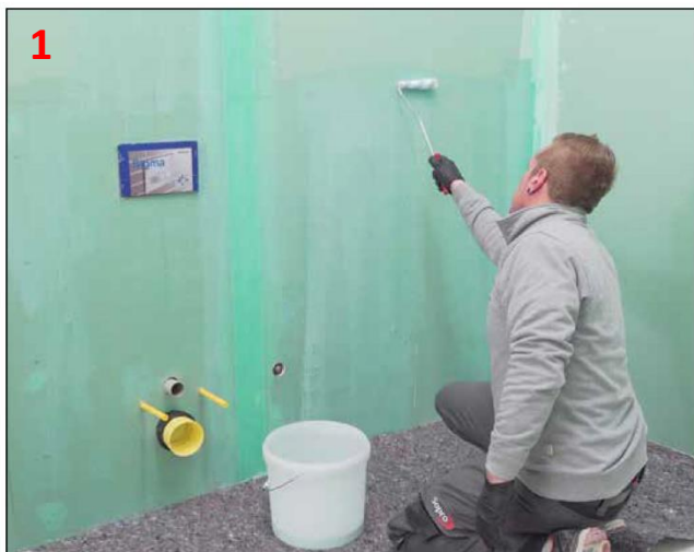
1 Podłoże chłonne zagruntować preparatem Sopro GD 749.
