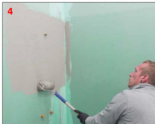
4 Klej Sopro FDK 415 lub zaprawę uszczelniającą Sopro DSF® RS 623 nanieść na całą powierzchnię.
