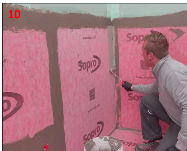
10 W narożach – w celu wykonania szczelnego złącza – nanieść klej Sopro FDK 415 lub zaprawę Sopro DSF® RS 623 na obie płaszczyzny, a następnie wkleić taśmę uszczelniającą Sopro AEB® 148 (bez pustek).
